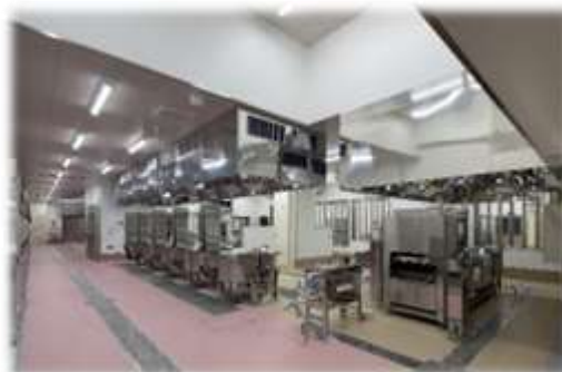
伊野給食センター内部
