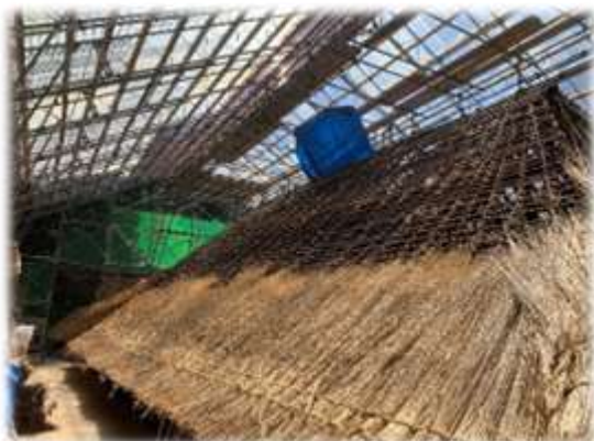
保存修理工事中の国指定重要文化財「山中家住宅」
