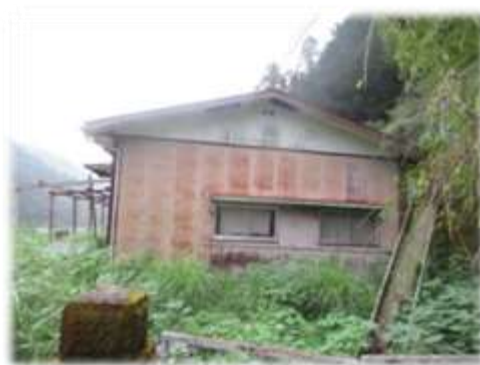
老朽化した旧下八川幼稚園(※除却済)
