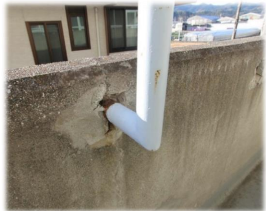
ベランダ手摺り部分爆裂（伊野中）※改修済
