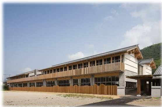
平成29年度に竣工した伊野小学校
