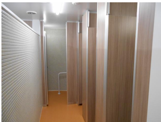
伊野中学校トイレ改修工事
