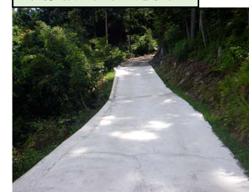
改修補強（実施後）
