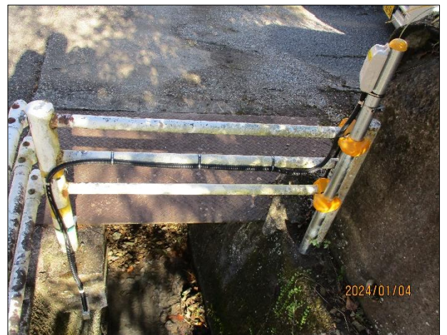
設置箇所①(近景)
