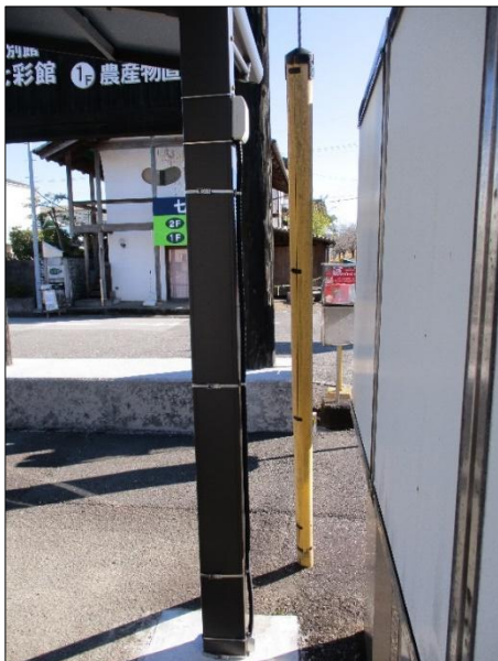
設置箇所①-2 (遠景)
