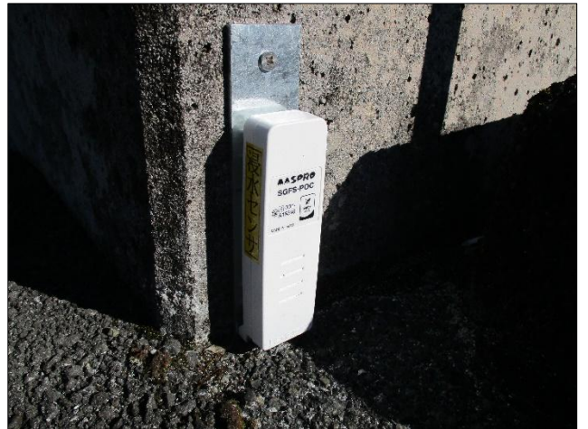
設置箇所①-1 (近景)
