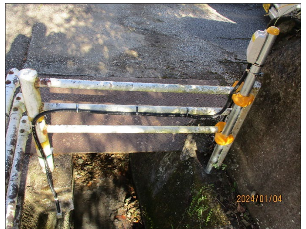
設置箇所①(近景)
