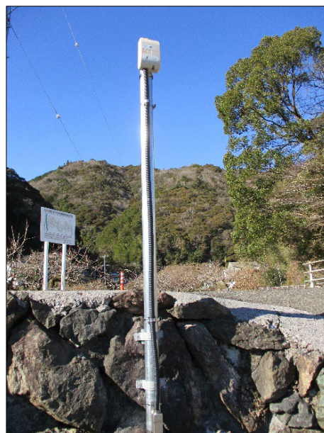
設置箇所② (近景)
