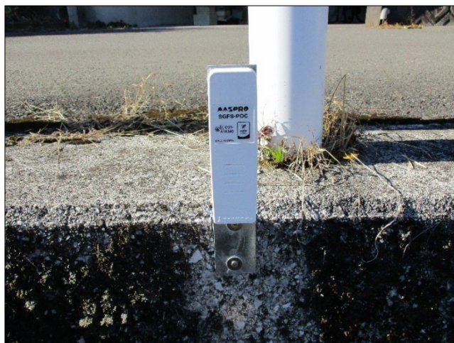
設置箇所①-2 (近景)
