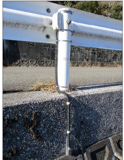
設置箇所①-1 (近景)
