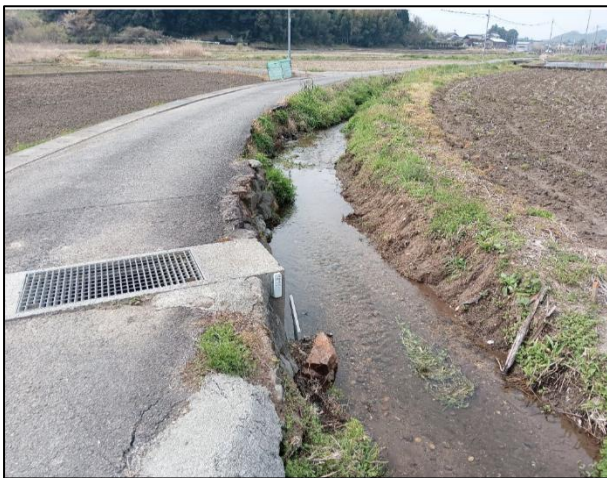
設置箇所（遠景）
