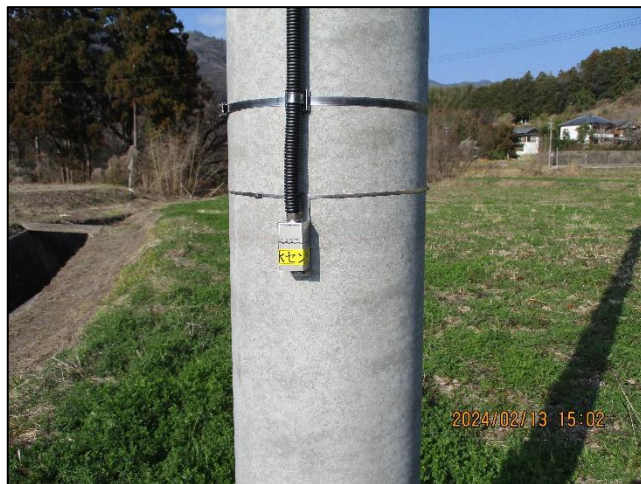
設置箇所③(近景)
