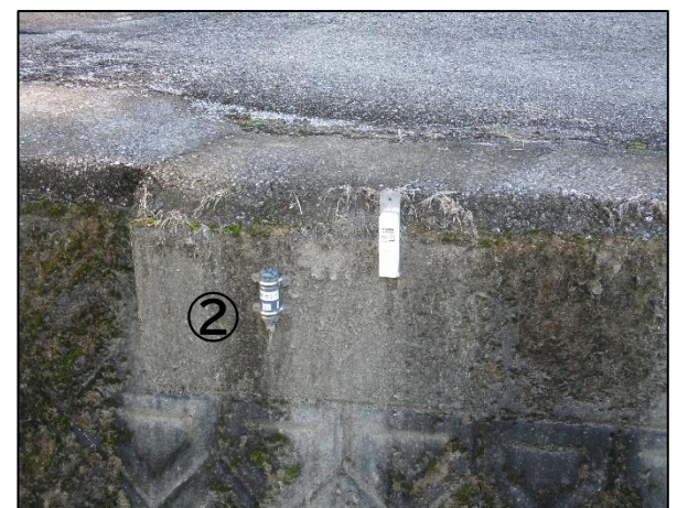
設置箇所②(近景)
