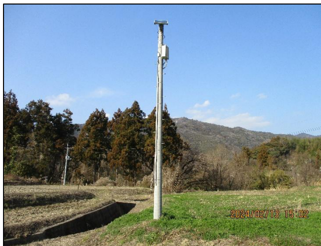
設置箇所③(遠景)
