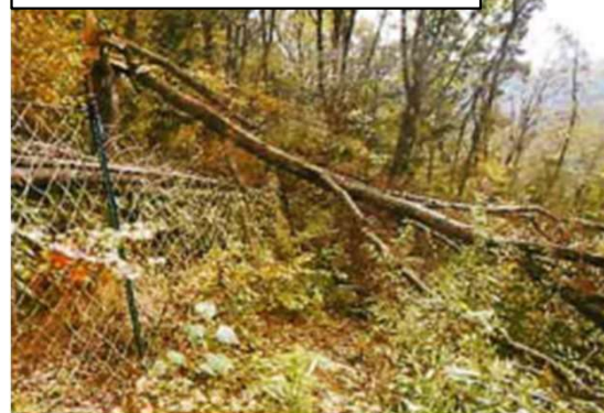
倒木による鳥獣害防止ネット損傷
