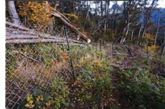
倒木の処理及びネットの張り直し
