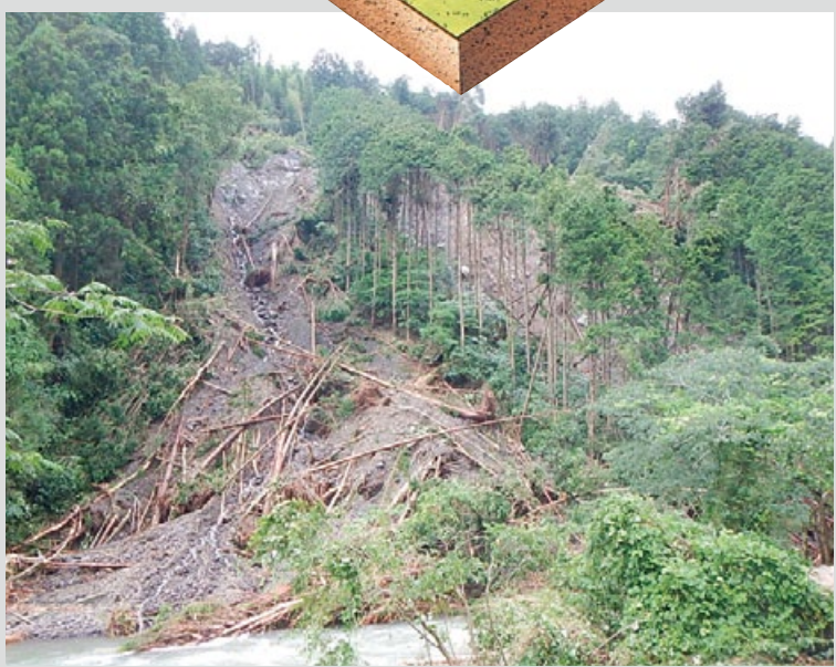
高知市鏡の瀧地区の地すべり 平成26年の台風第12号第11号による大雨で発生
