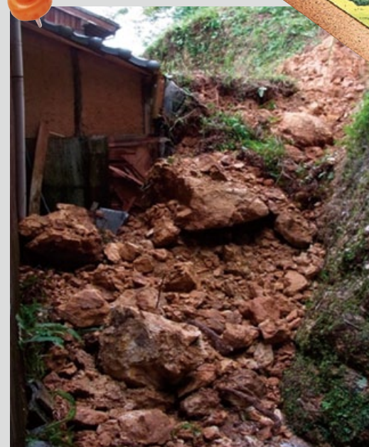
大月町弘見のがけ崩れ
