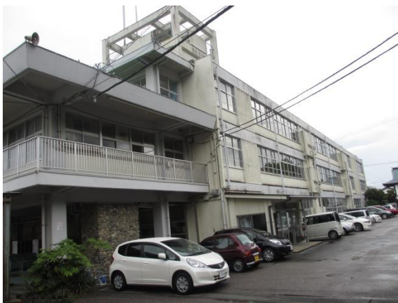
〔改築される伊野小学校〕
