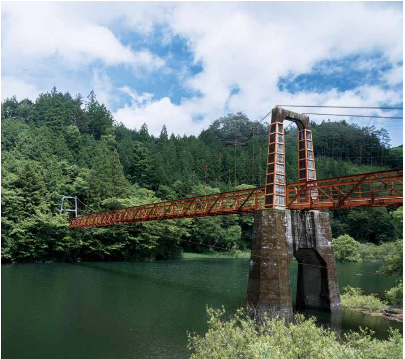
本川地区の長沢ダム湖上流に架かる旧越裏門橋。対岸の集落へ渡る手段として、昔から地域の人に親しまれています。
