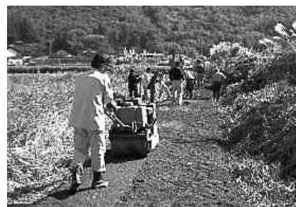
未舗装農道の舗装
