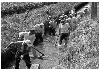
水路の泥上げ
