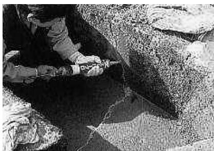
水路のひび割れ補修
