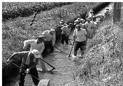
水路の泥上げ
