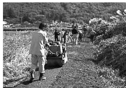
未舗装農道の舗装
