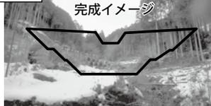
越裏門地区において、土石流などの土砂災害を防止するため、砂防堰堤の工事を行っています。
