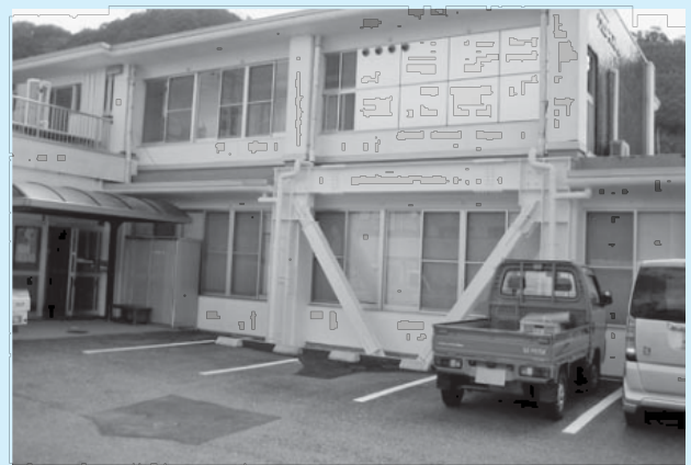
複合福祉施設ウェルネス伊野耐震補強工事 857万円
