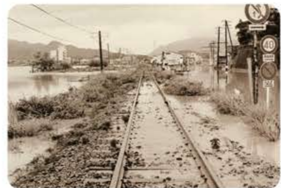
昭和50年、台風5号災害での北内地区から西向き状況。鉄道盛土を除き、周囲一帯が浸水している。
