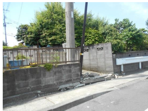
写真 地震時に倒壊・破損したブロック塀（熊本地震 いの町職員撮影）
