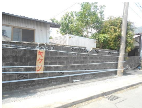
写真 地震時に倒壊・破損したブロック塀（熊本地震 いの町職員撮影）
