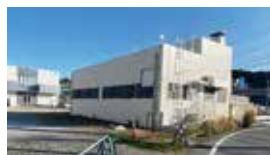
東浦ポンプ場
