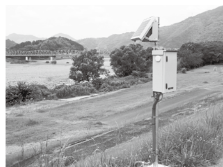
危機管理型水位計 仁淀川（大町町）
