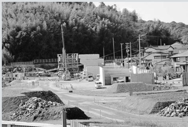
工事中西バイパス枝川IC(撮影日：2013年2月14日)
