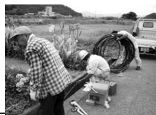
業者の方がボランティアで、水道工事をしてくださいました。
