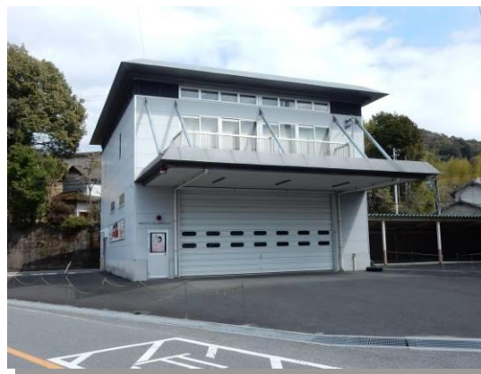
枝川コミュニティ消防センター
