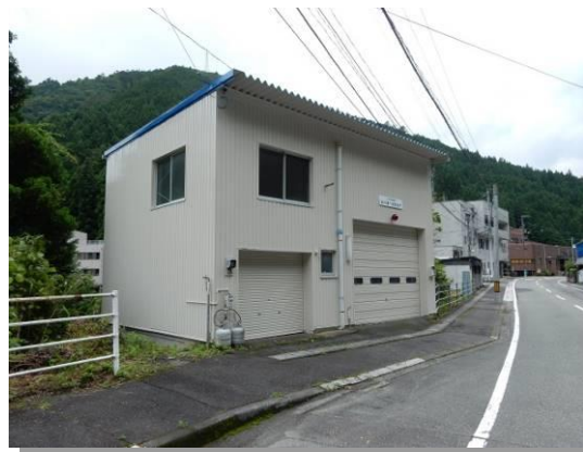
本川第1分団消防屯所
