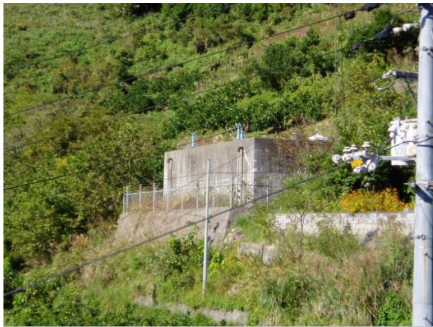
吾北・下八川配水池
