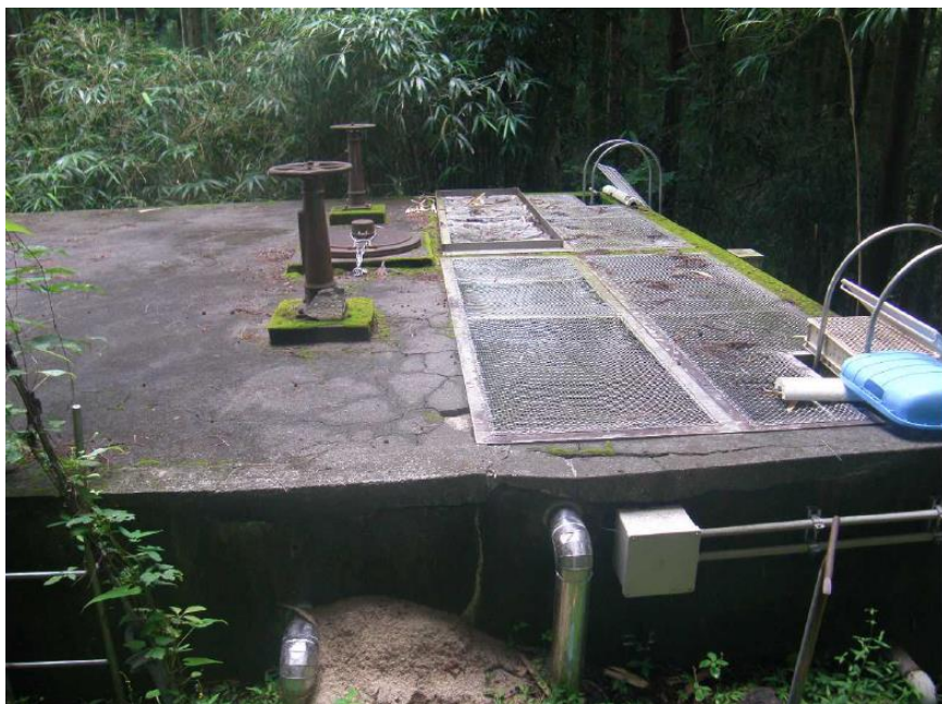
本川・大森緩速ろ過池
