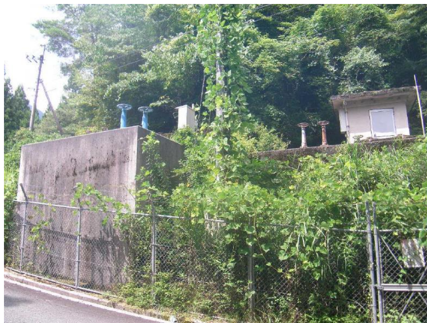
本川・大橋配水池
