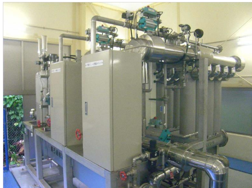
本川・長沢膜ろ過施設
