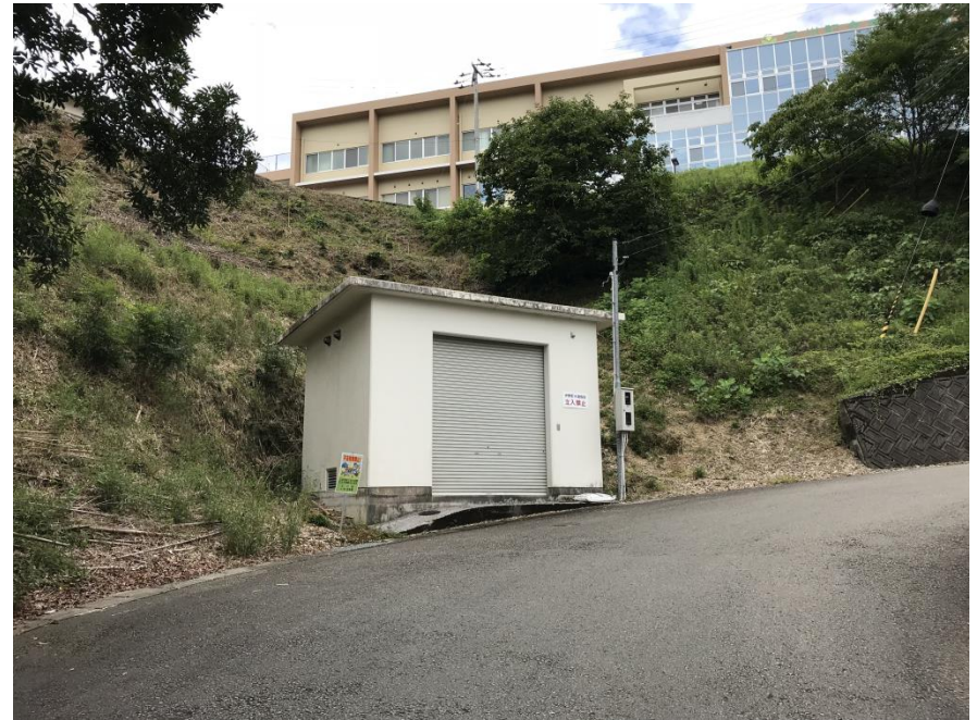
伊野・西山加圧ポンプ
